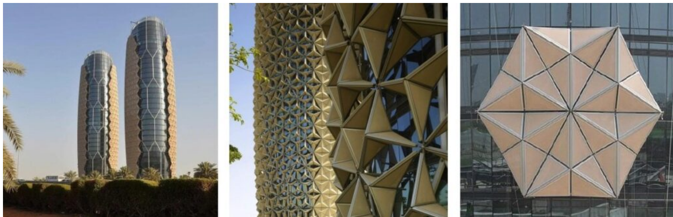
Aedas Architects, Al Bahar Tower, Abu Dhabi, veduta, motivo parietale e modulo base (parametric-architecture.com).
