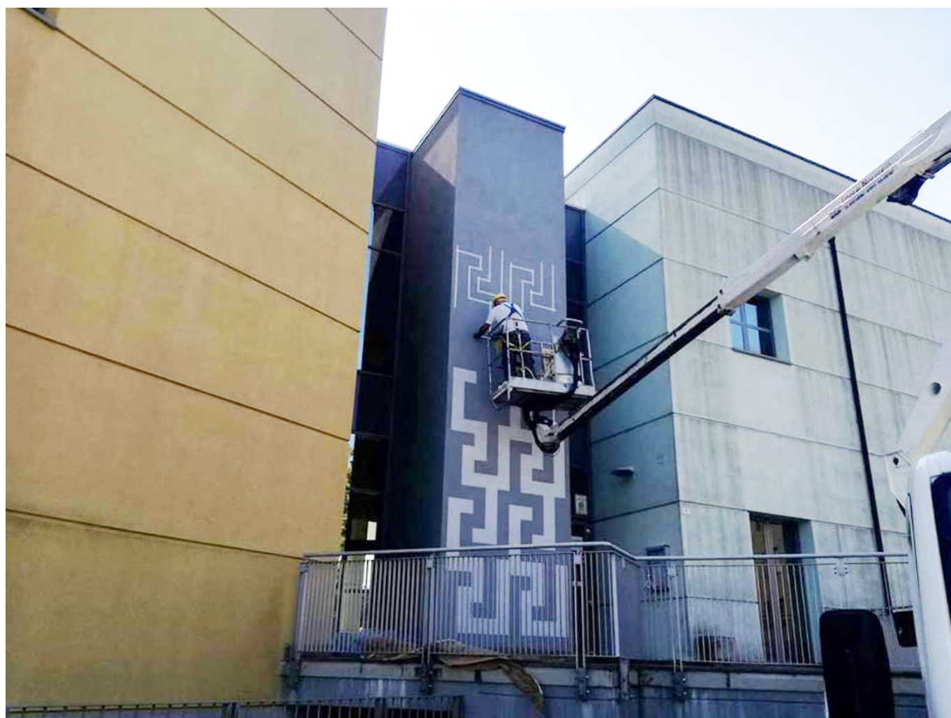
Una fase della lavorazione di "Nuvole", fregio decorativo progettato ed eseguito da Marco Lazzarato con la collaborazione tecnica di Giuseppe Giaquinta, per la sede municipale di Toscanella di Dozza (Bologna), XXVII Biennale del Muro Dipinto, 2017, intonachino su muro, m 9 x 2 ( www.murodipinto.com ).
