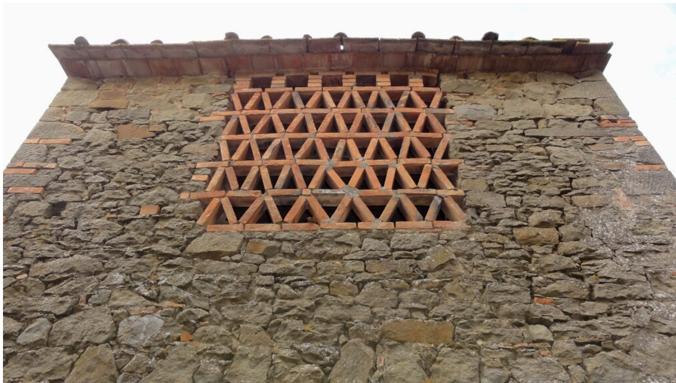
Graticcio di mattoni (mandolato) in edificio rurale a Lamole di Greve in Chianti, Firenze ( www.ilcapochiave.it ).
