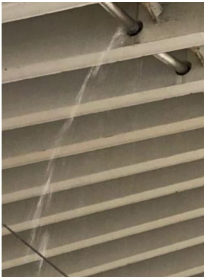
a) Un'immagine della banchina allagata. b) Perdita d'acqua piovana da uno dei tubi di scarico che attraversano la volta (photo credits Augusto Giuffredi).
