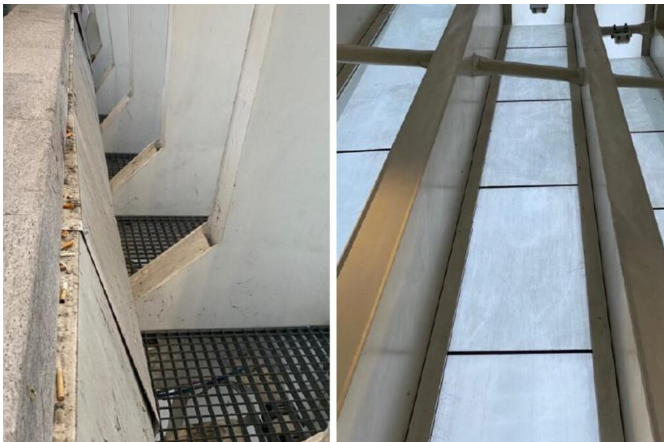
a) Giunzione tra parapetto e nervature metalliche all'altezza della banchina d'imbarco. b) Un tratto delle vetrate ascendenti col consueto deposito di polvere e smog (photo credits Augusto Giuffredi).
