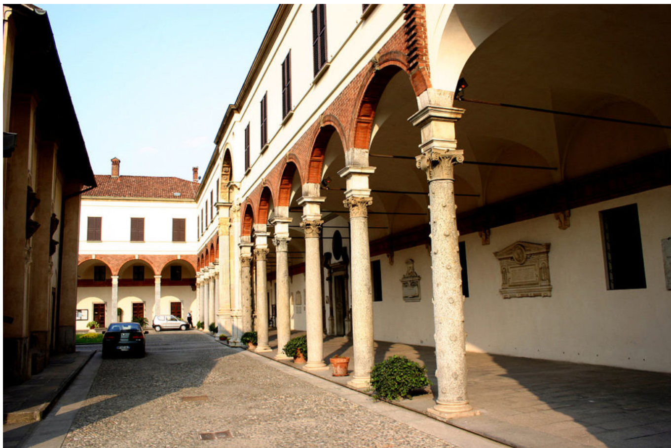
Veduta del portico bramantesco della canonica della basilica S. Ambrogio a Milano, con in primo piano una delle colonne simulanti la struttura originaria di un tronco d'albero, ultimo decennio del secolo XV, ricostruito dopo i bombardamenti del 1943 (Giovanni Dall'Orto/Wikimedia Commons).
